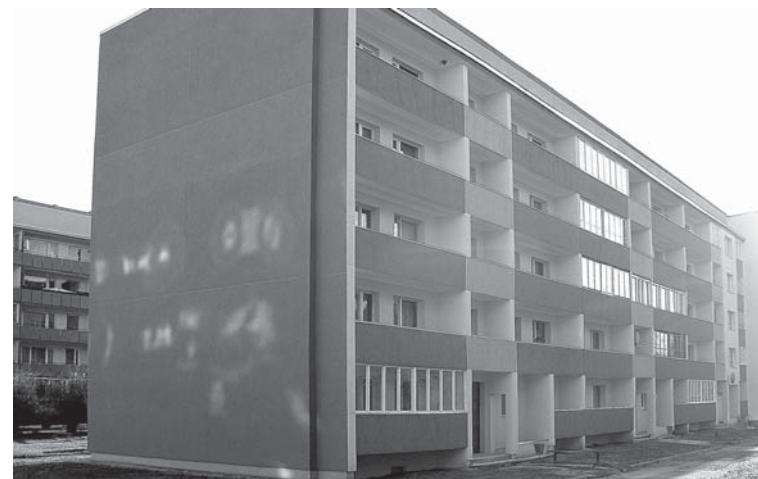
Daudzdzīvokļu ēka Gaismas ielā 3, Kuldīgā, pirms rekonstrukcijas un pēc... Ēkai ir nosiltināta fasāde, ēkas cokols un pamati, bēniņi un pagraba pārsegums, bet kāpņu telpās ir nomainīti logi, renovēts arī jumta segums. Siltumenerģijas patēriņš karstajam ūdenim un apkurei pirms ēkas atjaunošanas 2009./2010. gada apkures sezonā bija 164,11 kWh/m<sup>2</sup>, bet pēc renovācijas siltumenerģijas patēriņš samazinājās par 27,83%. 2010./2011. gada apkures sezonā tas bija 118,43 kWh/m<sup>2</sup>.
